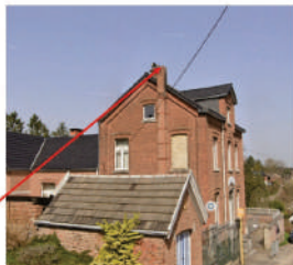
Dalle de cheminée à placer
