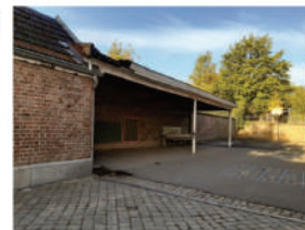
Garage, porche et accès cours
