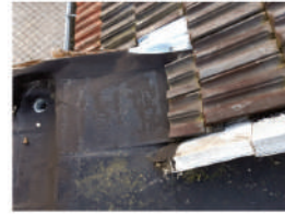
Raccord toitures: prémi et garage
