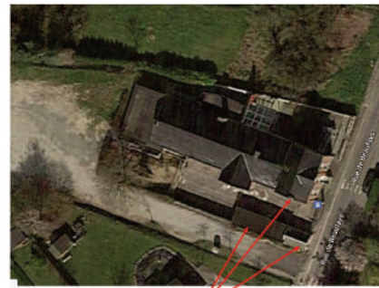
Vue des toitures
