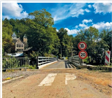
Pont de la Fenderie
